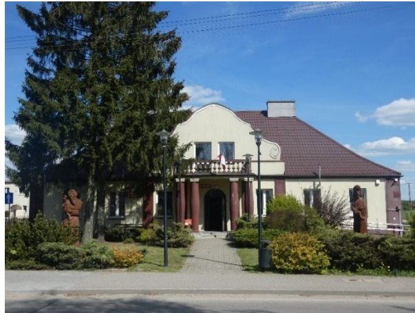
Fot. Historyczny budynek administracyjny w centrum Karniewa
