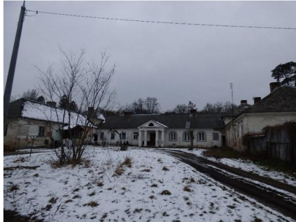
Fot. 13. Budynek tzw. podkowy w Podzamczu
