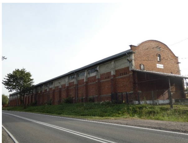
Fot. 6. Magazyn wysłodków w dawnej Cukrowni Krasiniec
