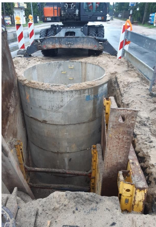
Budowa sieci kanalizacji ogólnospławnej wraz z odcinkami sieci do granic nieruchomości w ulicach: Ekspresowej, Liczydło i Nastawniczej w dzielnicy Białołęka m.st. Warszawy
