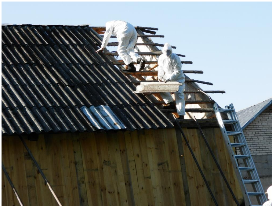
Unieszkodliwienie (demontaż) wyrobów zawierających azbest
