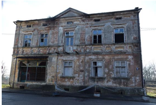
Kamienica na Pl. O. Koźmińskiego w Nowym Mieście nad Pilicą.
