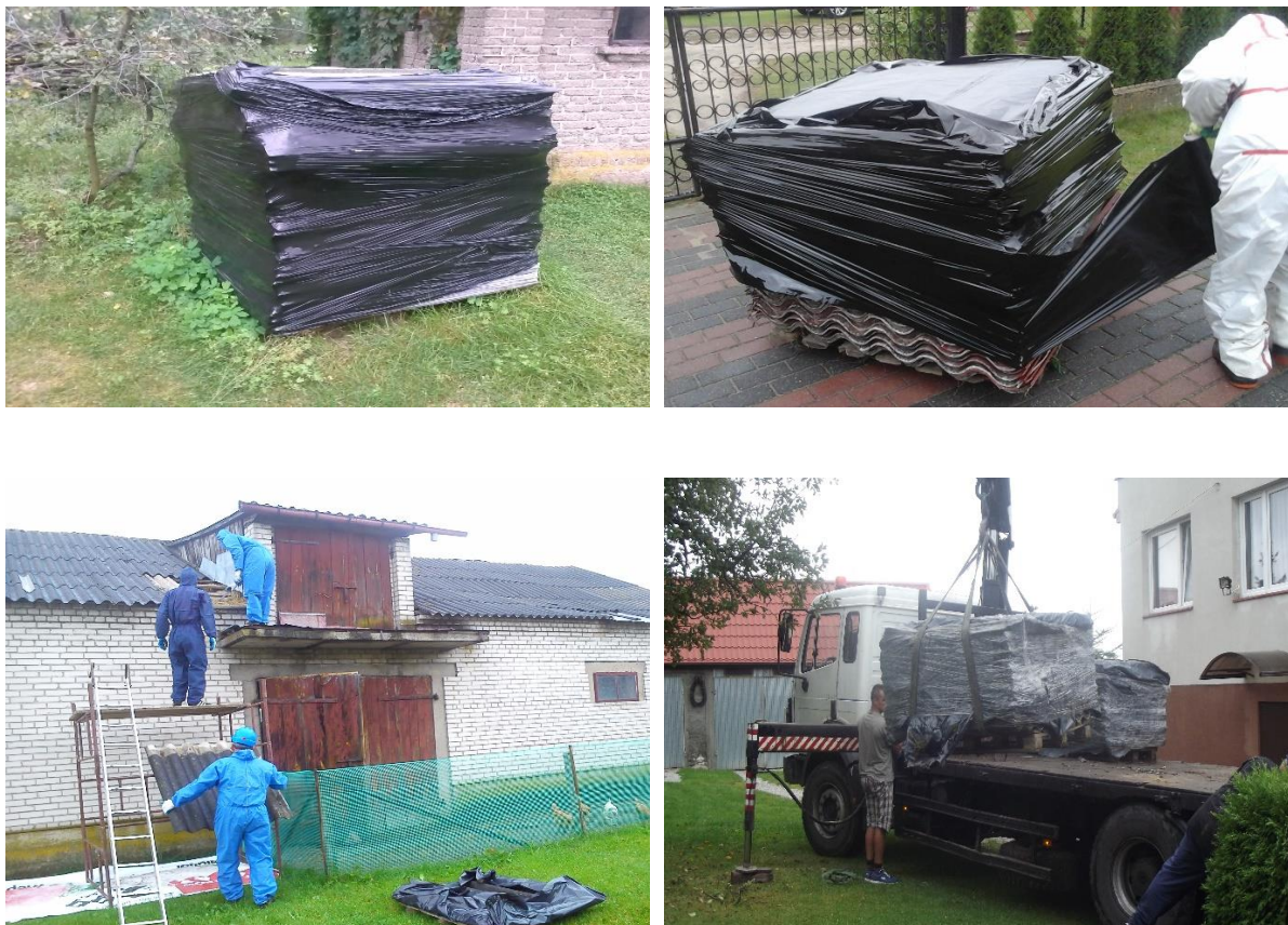
Unieszkodliwienie wyrobów zawierających azbest na terenie gminy Szczawin Kościelny
