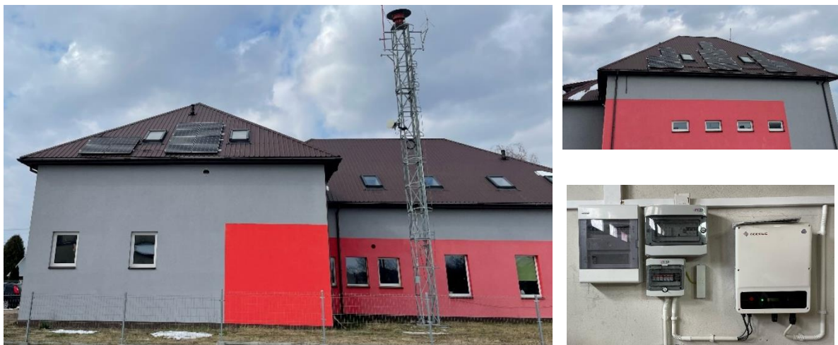
Zakup i montaż instalacji fotowoltaicznej dla Ochotniczej Straży Pożarnej w Ostrówku
