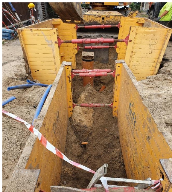
Budowa sieci kanalizacyjnej w ul. Kościuszki oraz w drodze dojazdowej do posesji przy ul. Kościuszki 13 wraz z odcinkami sieci na terenie Dzielnicy Wesoła m.st. Warszawy
