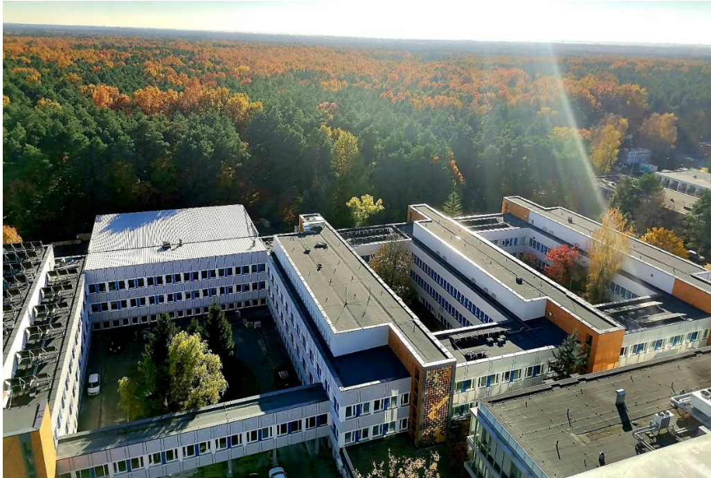
Termomodernizacja budynków Instytutu "Pomnik Centrum Zdrowia Dziecka" w Warszawie
