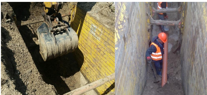
Budowa sieci kanalizacyjnej w drodze dojazdowej do ul. Trakt Lubelski w Warszawie na terenie Dzielnicy Wawer
