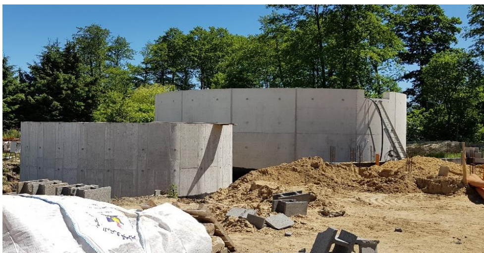
Budowa oczyszczalni ścieków w miejscowości Ruda Talubska, gm. Garwolin
