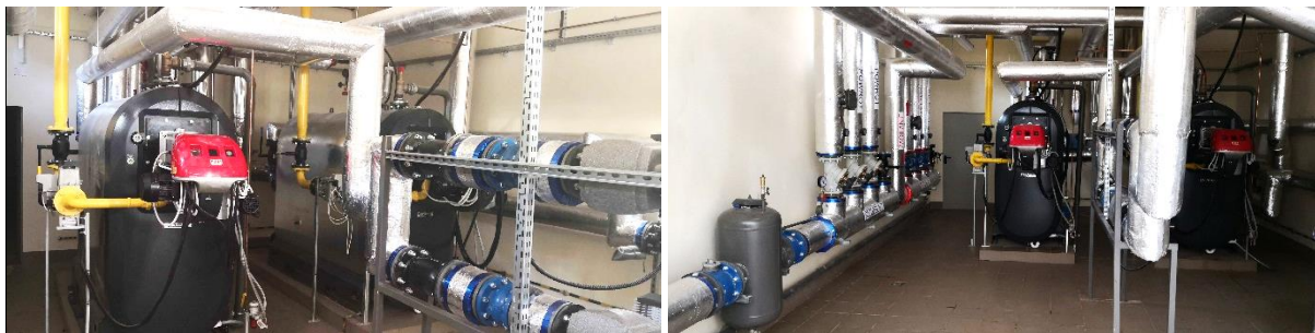
Modernizacja kotłowni węglowej na kotłownię zasilaną gazem ziemnym i olejem opałowym lekkim w Przysusze (po realizacji przedsięwzięcia)
