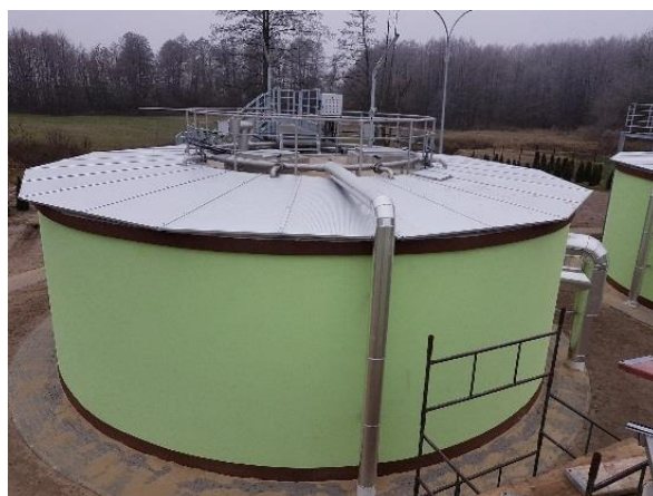
Budowa oczyszczalni ścieków w miejscowości Ruda Talubska, gm. Garwolin
