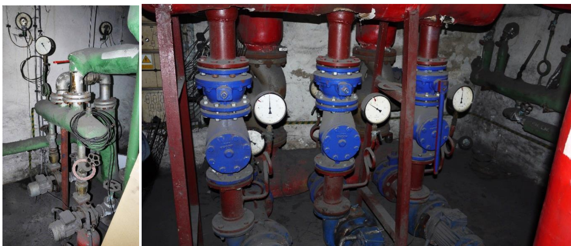
Modernizacja kotłowni węglowej na kotłownię zasilaną gazem ziemnym i olejem opałowym lekkim w Przysusze (przed realizacją przedsięwzięcia)
