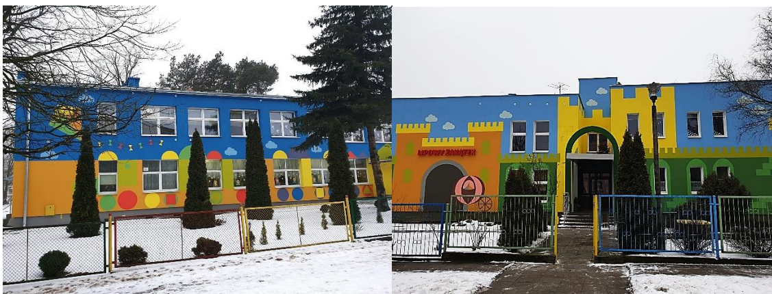
Termomodernizacja budynków przedszkoli w Pionkach
