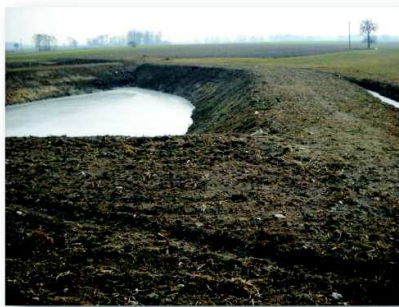
Budowa ziemnego zbiornika wodnego w miejscowości Pliszki, gmina Paprotnia.
