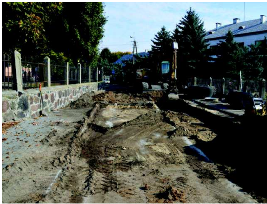
Budowa kanalizacji deszczowej w ul. Kościelnej w Makowie Mazowieckim.
