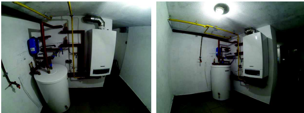
Wymiana kotła gazowego atmosferycznego na gazowy kondensacyjny, przy ul. Kilińskiego 27A w Ostrołęce.
