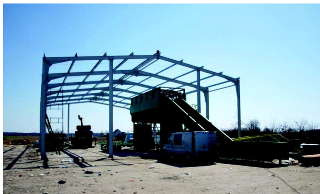
Budowa linii do sortowania odpadów komunalnych w miejscowości Lucin.
