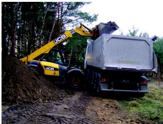
Usuwanie skażonej gleby w ramach zadania pn. „Usunięcie skutków skażenia terenów leśnych w Nadleśnictwie Gostynin”.
