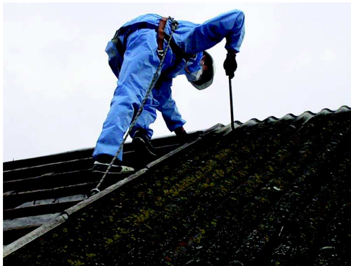
Demontaż wyrobów zawierających azbest z terenu gminy Dobrze.
