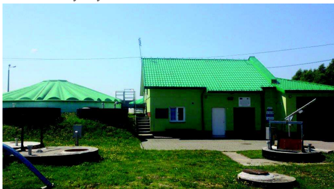
Rozbudowa oczyszczalni ścieków w Stoczku, gmina Stoczek.
