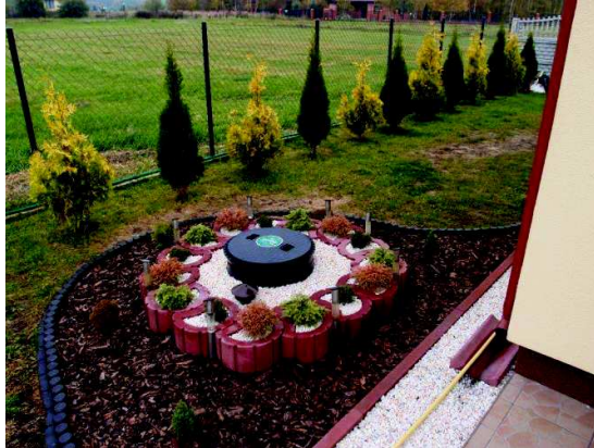
Budowa przydomowej oczyszczalni ścieków w miejscowości Stare Budy Radziejowskie, gmina Radziejów.
