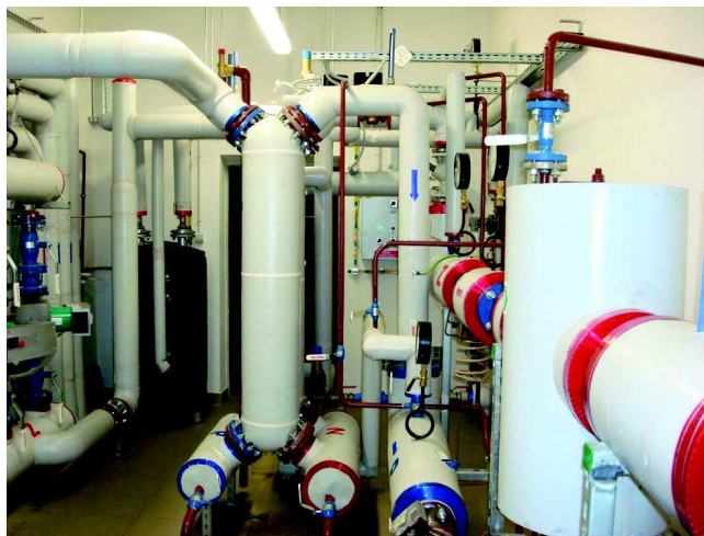
Modernizacja węzła cieplnego w budynku Komendy Stołecznej Policji przy ul. Sierakowskiego 7 w Warszawie.
