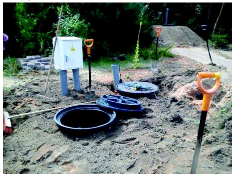
Budowa przydomowych oczyszczalni ścieków w gminie Liw.
