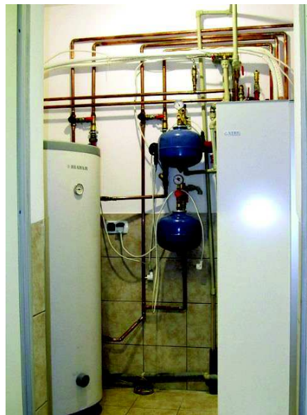
Montaż pompy ciepła w miejscowości Krajęczyn, gmina Joniec.
