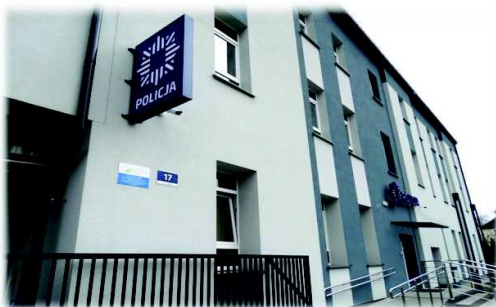
Termomodernizacja budynku Komisariatu Policji Warszawa-Wilanów - zadanie realizowane przez Komendę Stołeczną Policji w Warszawie.
