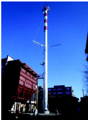
Remont komina w ciepłowni przy ul. Armii Ludowej 10 w Mińsku Mazowieckim.
