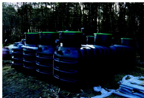
Budowa oczyszczalni ścieków przy Publicznej Szkole Podstawowej w miejscowości Blochy, gmina Długosiodło.
