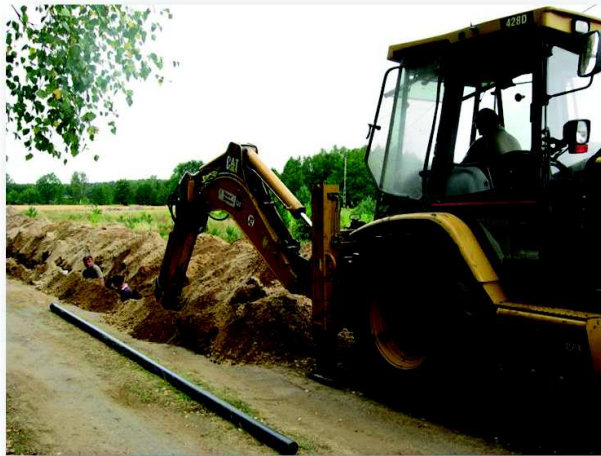
Rozbudowa sieci wodociągowej z przyłączami w miejscowości Stare Bosewo.
