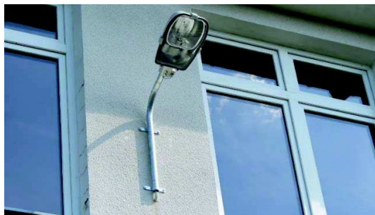
Modernizacja oświetlenia zewnętrznego w Publicznej Szkole Podstawowej w Zgórzu.
