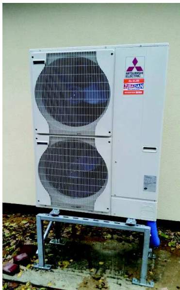
Montaż pompy ciepła powietrze - woda w miejscowości Nowa Wieś, gmina Michałowice.
