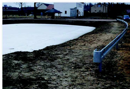
Przebudowa wiejskiego stawu w Dąbrówce, gmina Czerwonka.
