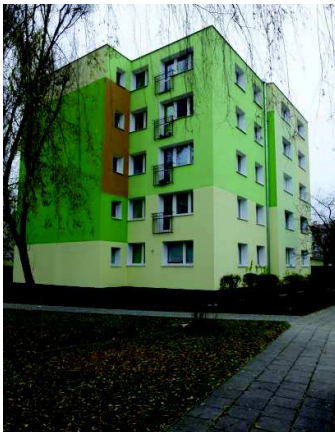
Termomodernizacja budynku mieszkalnego przy ul. Radarowej 4 w Warszawie.
