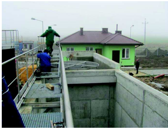
Budowa oczyszczalni ścieków w Jędrzejów Nowym, gmina Jakubów.
