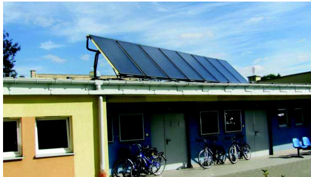
Montaż zestawów solarnych do podgrzewania ciepłej wody użytkowej w budynku laboratorium kryminalistycznego przy ul. Limanowskiego 95 w Radomiu.
