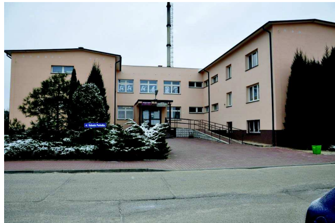
Termomodernizacja budynku Przedszkola w Jabłonie Lackiej.
