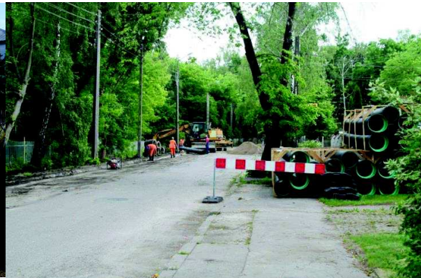
Budowa kanalizacji deszczowej na odcinku od ul. Orszagha do ul. Wołomińskiej w Kobylce.
