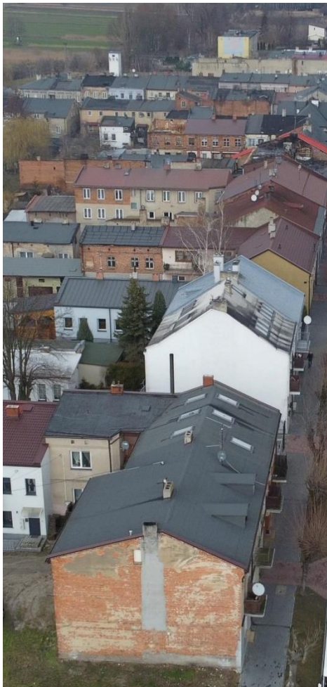
Fotografia 20. Kamienice w centrum Błaszek
