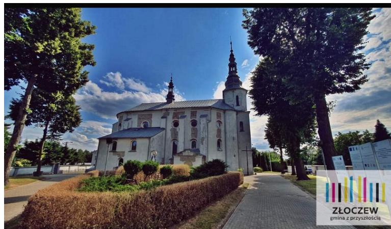
Remont elewacji zewnętrznej zabytkowego kościoła pw. św. Andrzeja Apostoła w Złoczewie. Kwota ogólna 469.387,76 zł 9.387,76 zł wkład własny Gminy Złoczew 460.000 zł Rządowy Programu Odbudowy Zabytków
