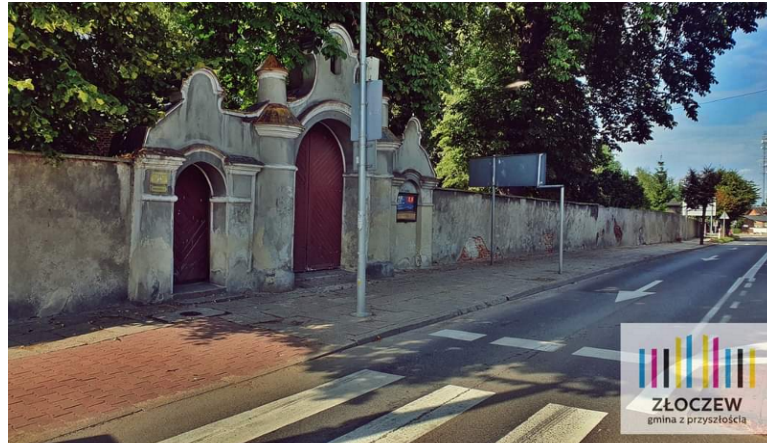
Remont częściowy ogrodzenia i bram w Zespole Klasztornym Mniszek Kamedułek w Złoczewie. Kwota ogólna 469.200 zł 9.384 zł wkład własny Gminy Złoczew 459.816,01 zł Rządowy Programu Odbudowy Zabytków
