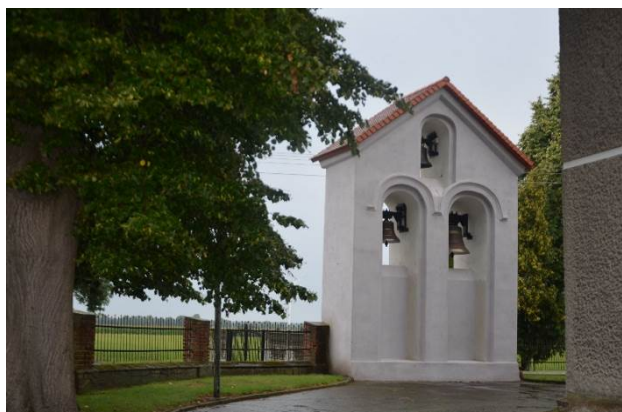
Dzwonnica w Unikowie (2023 r.)
