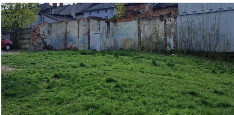
Mur, na którym przewiduje się realizację muralu
