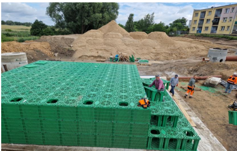
Relizacja prac rewaloryzacyjnych
