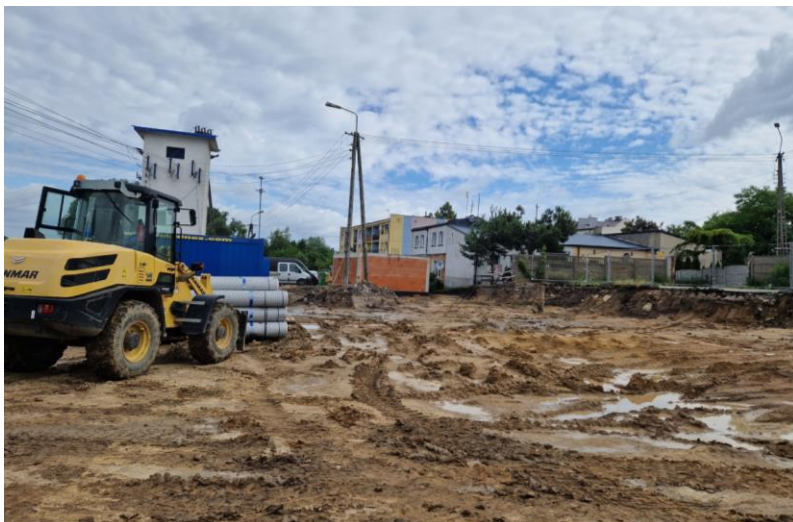
Prowadzone prace z zakresu rewaloryzacji
