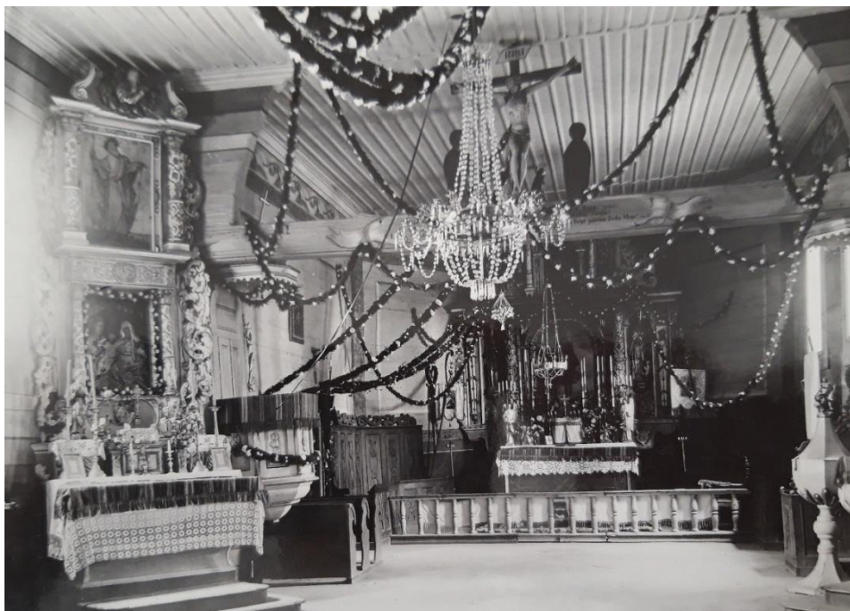
Korczew kościół pw. Św. Katarzyny. Fotografia archiwalna z okresu międzywojennego. Źródło: IS PAN
