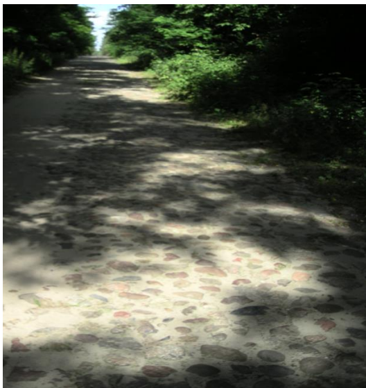
Suliszew - droga brukowa o długości 227 m
