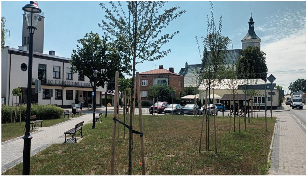
Bolimów- przestrzeń zrewitalizowana
