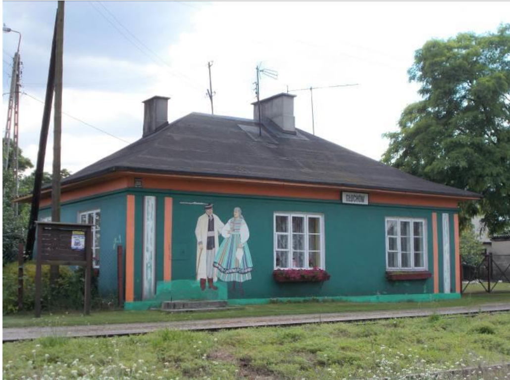
Głuchów budynek kolejki
