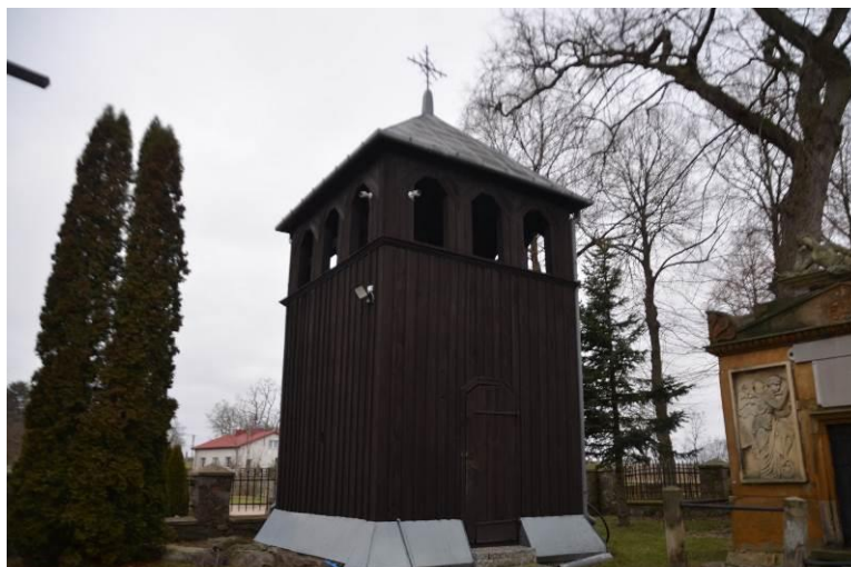
Wymagający zabezpieczeń dzwonnica w Starej Rawie
