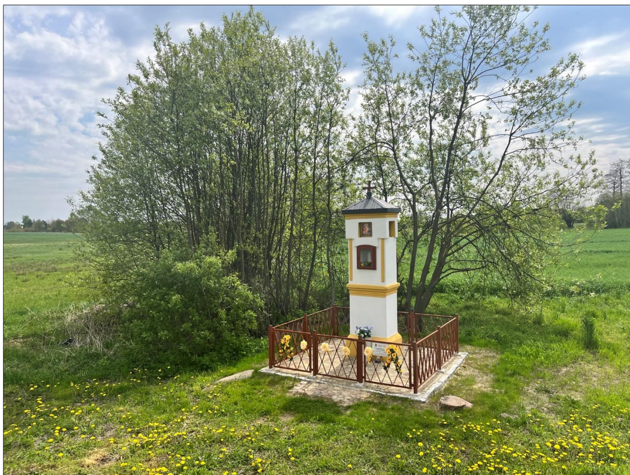
Fot. 15. Kapliczka rzymsko-katolicka w Olszowej: A. przed remontem, B. po remoncie (2022 r.) Kolorystyka kapliczki została odtworzona pod nadzorem konserwatorskim.
