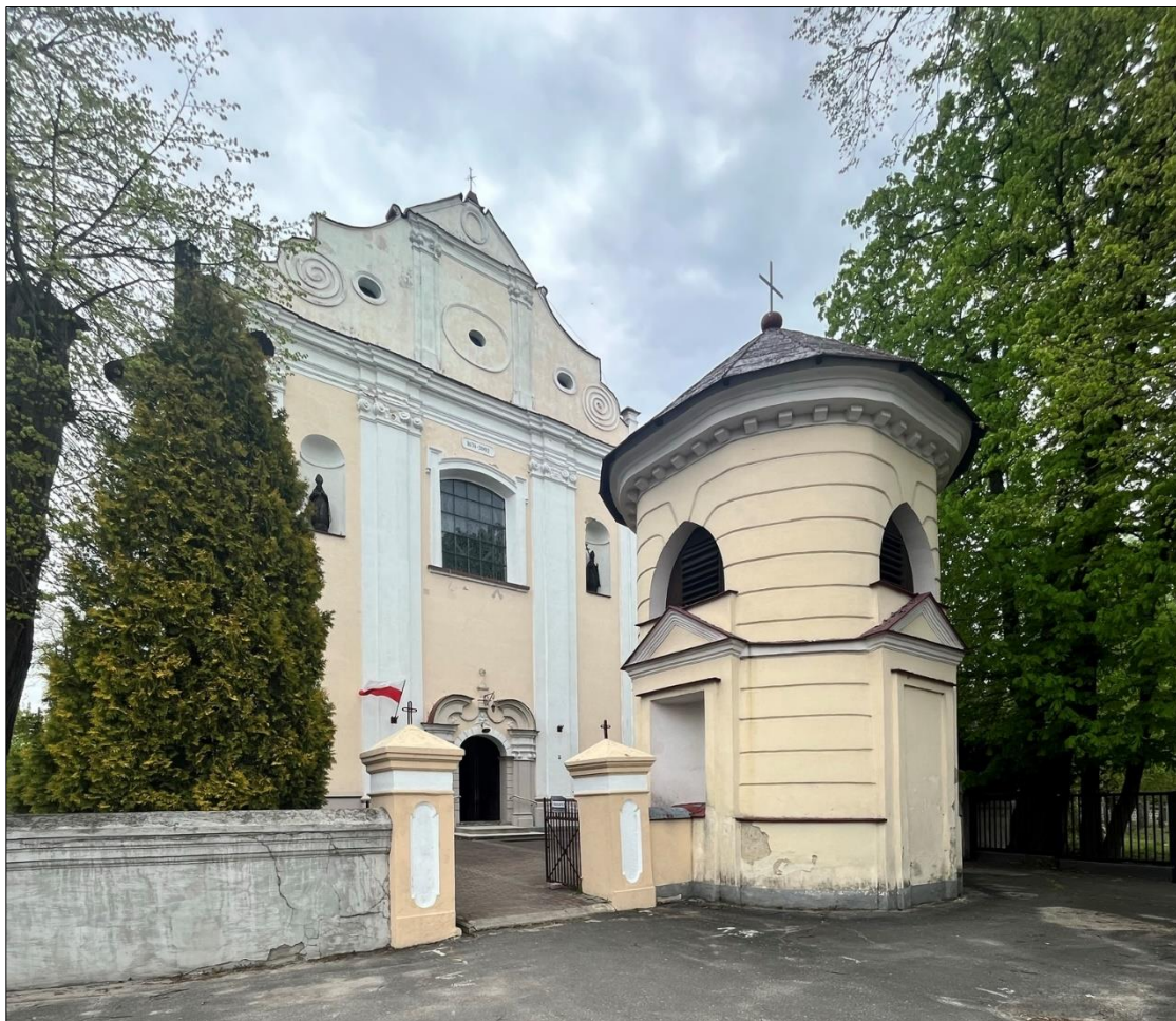
Fot. 6. Dzwonnica w zespole kościoła parafialnego rzymsko-katolickiego p.w. św. Wojciecha w Ujeździe Źródło: fotografia własna.
