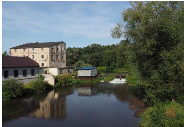
Elektrownia wodna na rzece Warta w miejscowości Działoszyn
