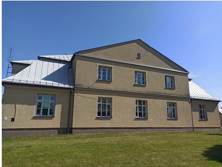
Elewacja budynku Domu Pomocy Społecznej
