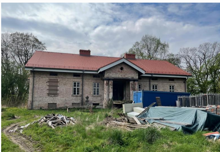
Zdjęcie. Dwór elewacja południowa (stan obecny - kwiecień 2023 r.) Źródło: fot. Anna Rek-Ancuta
