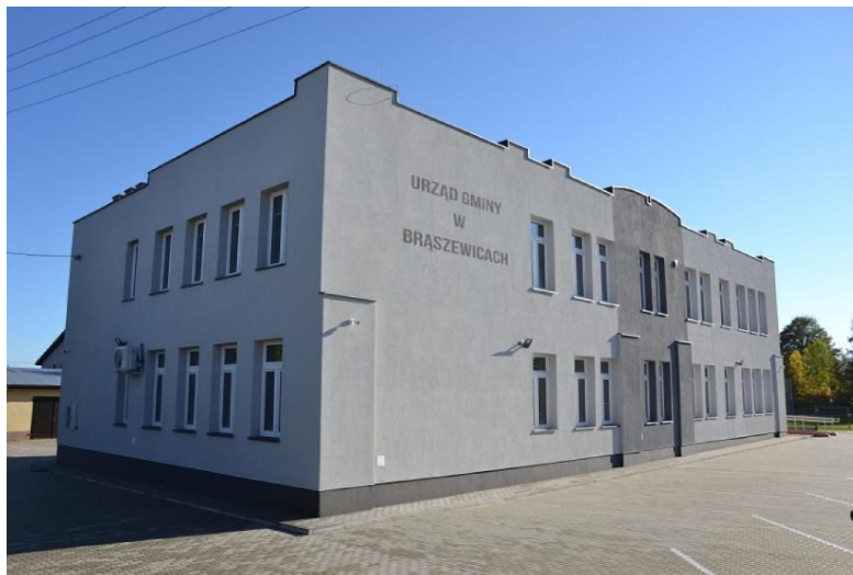
Nowa siedziba Urzędu Gminy Brąszewice
