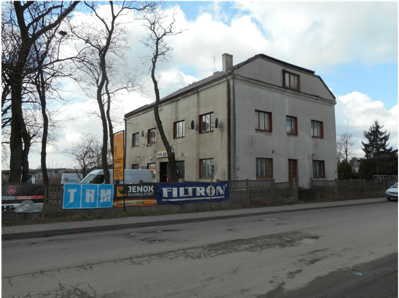
Stacja kolejki wąskotorowej
