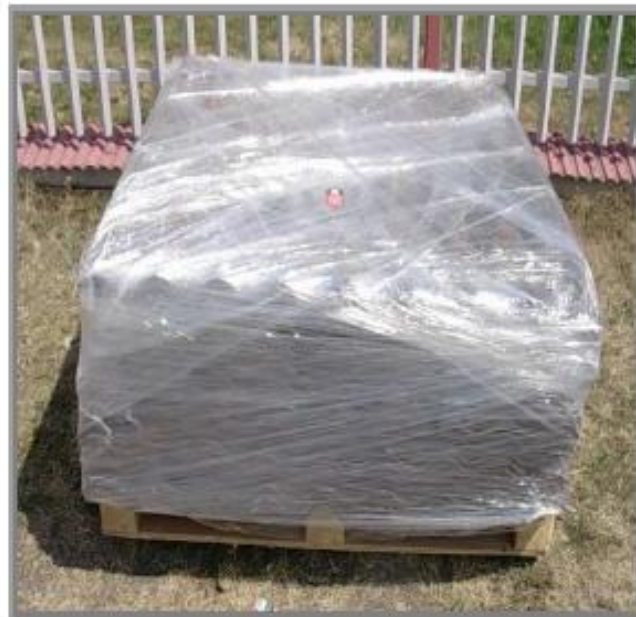
Zdjęcie 9. Prawidłowy sposób pakowania odpadów we właściwie oznakowane worki foliowe, ich powierzchnia zewnętrzna po zakończeniu czynności zostaje odkurzona.
