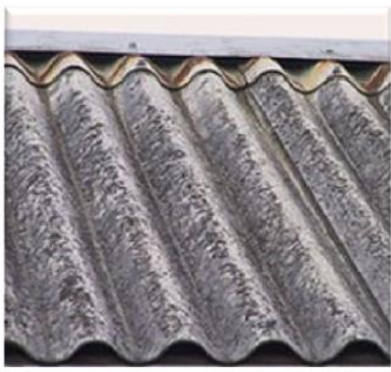
Zdjęcie 4. Płyty faliste azbestowo-cementowe.
