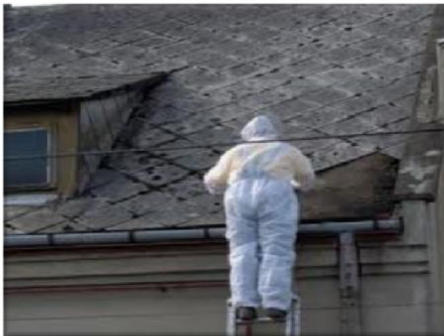
Zdjęcie 5. Płyty płaskie prasowane tzw. szablony lub płyty „karo”.
