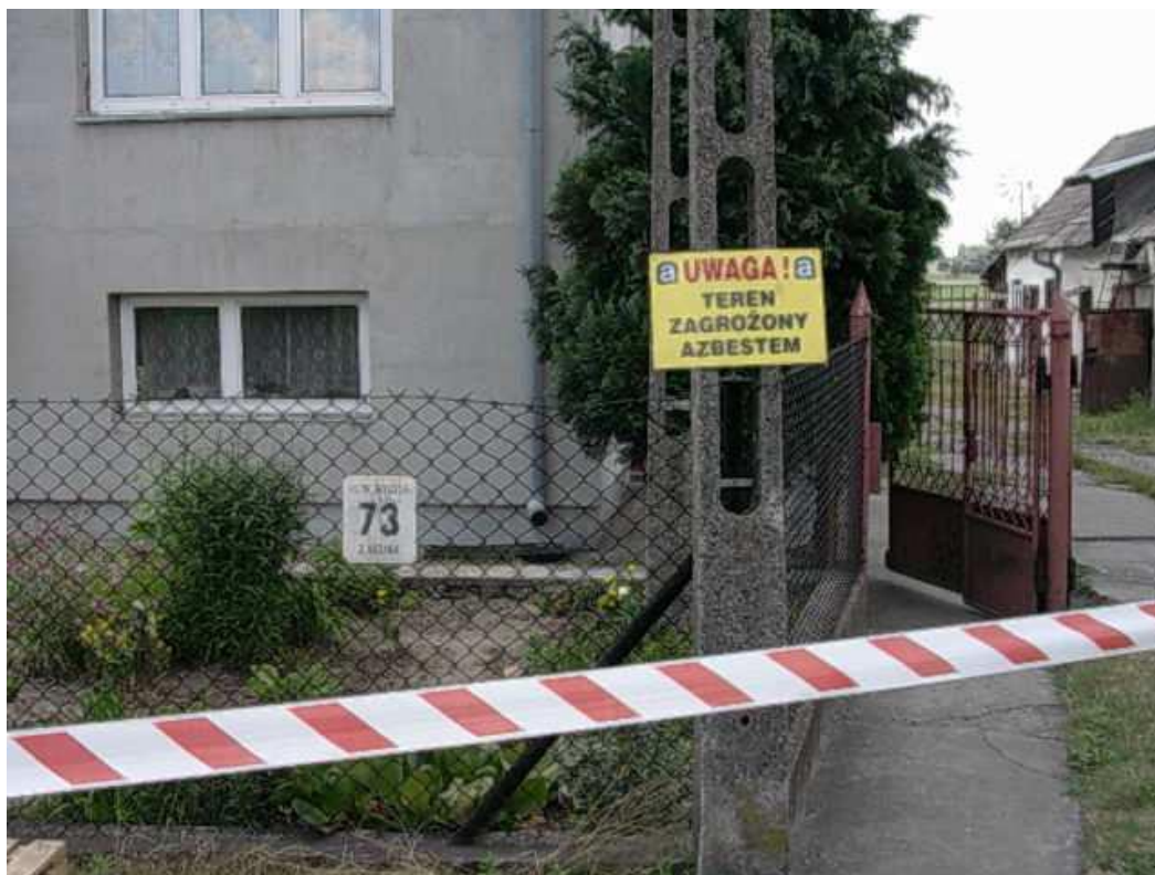
Zdjęcie 11. Prawidłowy sposób zabezpieczenia terenu zagrożonego azbestem.
