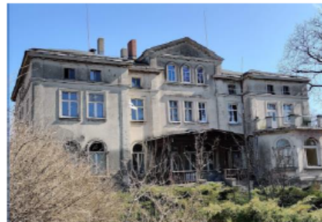
Fotografia 27. Widok na Pałac w Konradowie.
