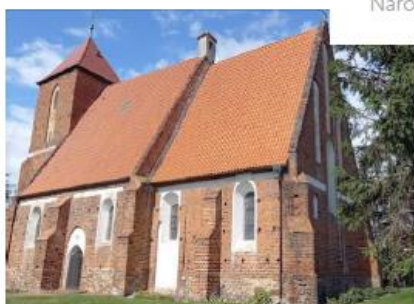
Fotografia 11. Widok na Kościół filialny pw. św. Jerzego w Przyczynie Górnej.
