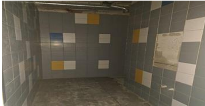
Zdjęcie 17 Budowa sali gimnastycznej przy szkole podstawowej w Baczyńie (pomieszczenie łazienki)
