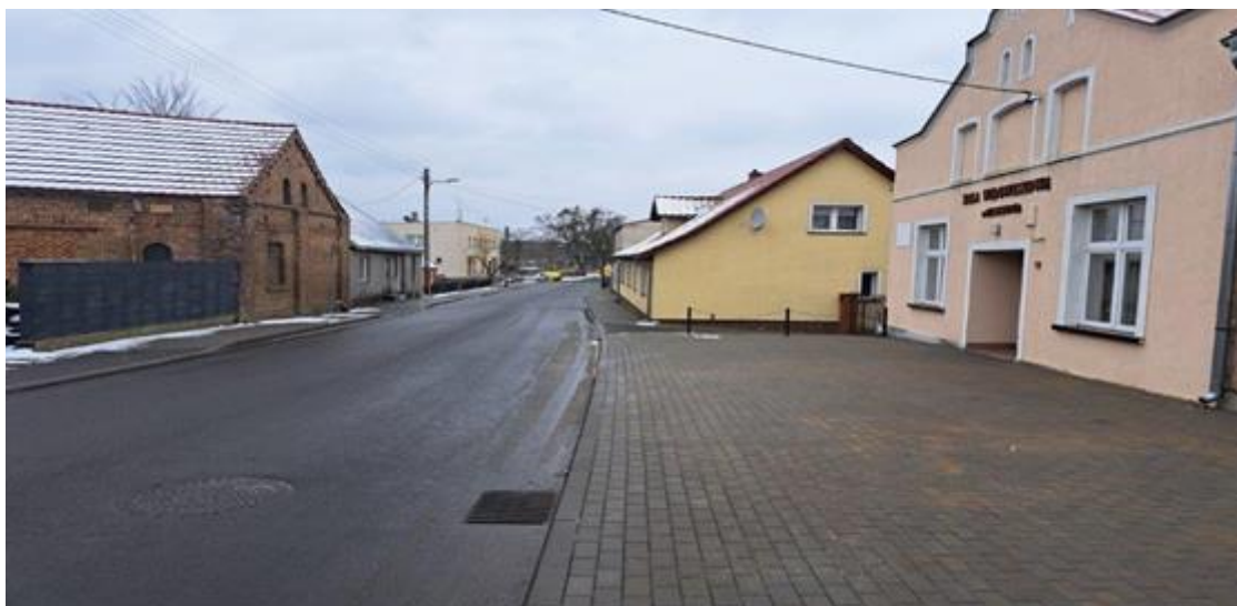
Zdjęcie nr 4 Przebudowa dróg powiatowych 1419F w ciągu ul. Myśluborska
