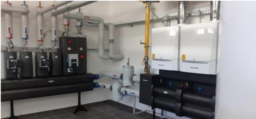
Zdjęcie 15 Modernizacja kotłowni w szkole podstawowej w Baczynie
