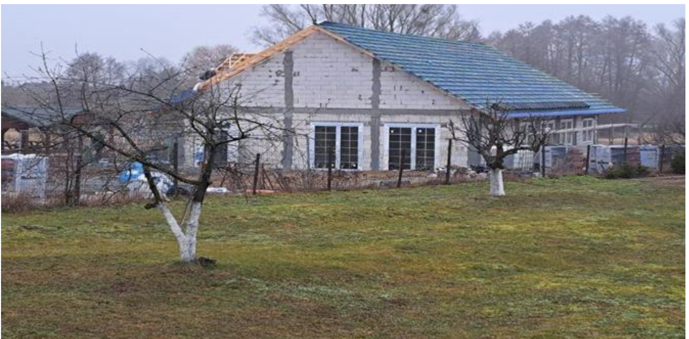
Zdjęcie nr 23 Budowa sali wiejska w Marwicach
