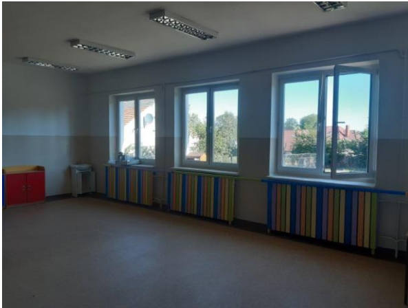
Zdjęcie nr 20 Remont szkoły podstawowej w Stawie
