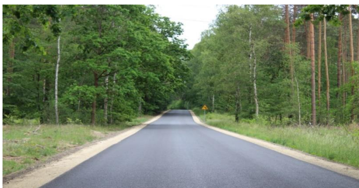
Zdjęcie nr 3 droga nr 1420F Wysoka-Ściechów, odcinek 2
