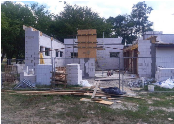
Zdjęcie nr 18 Rozbudowa OSP Lubno
