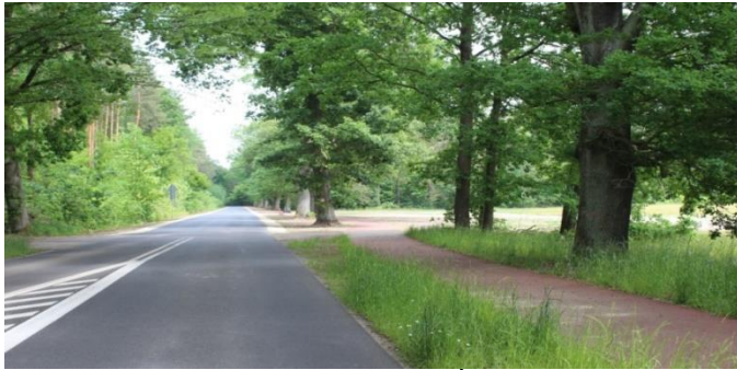
Zdjęcie nr 4 droga nr 1420F Wysoka-Ściechów, odcinek 2
