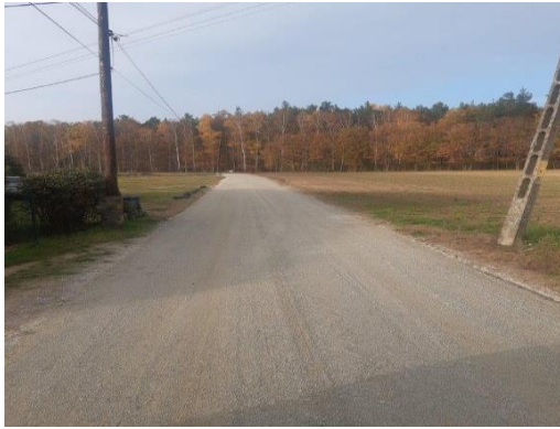
Zdjęcie nr 17 Droga gminna nr 002824F w Brzeźnie
