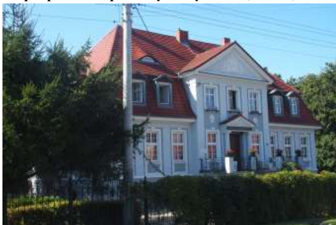
Zdjęcie nr 9. Pałac w Bądzowie (nr 30A)
