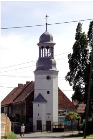
Zdjęcie nr 12. Kaplica – dzwonnica, Przedmoście
