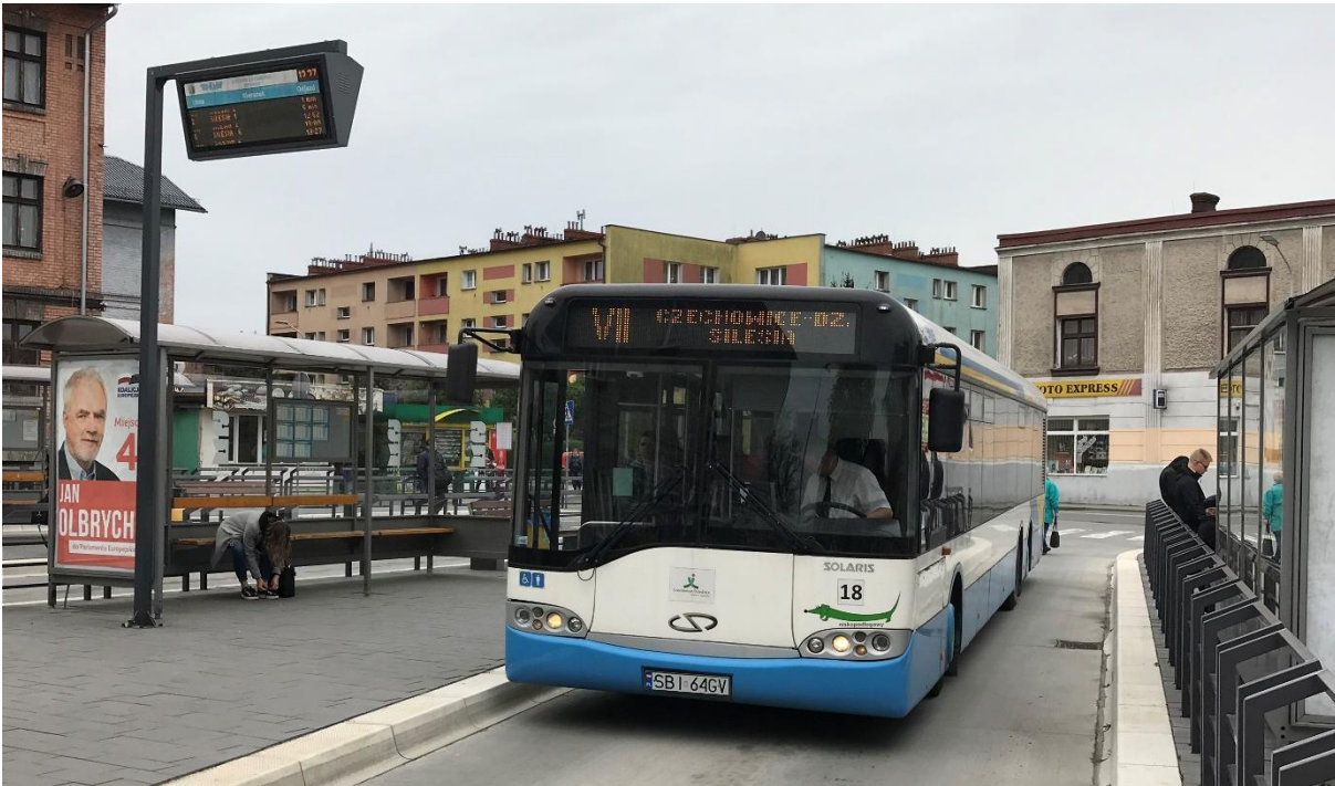
Rys. 10.2 Przykład wyposażenia przystanku autobusowego w tablicę z dynamicznym systemem informacji pasażerskiej (Czechowice-Dziedzice)
