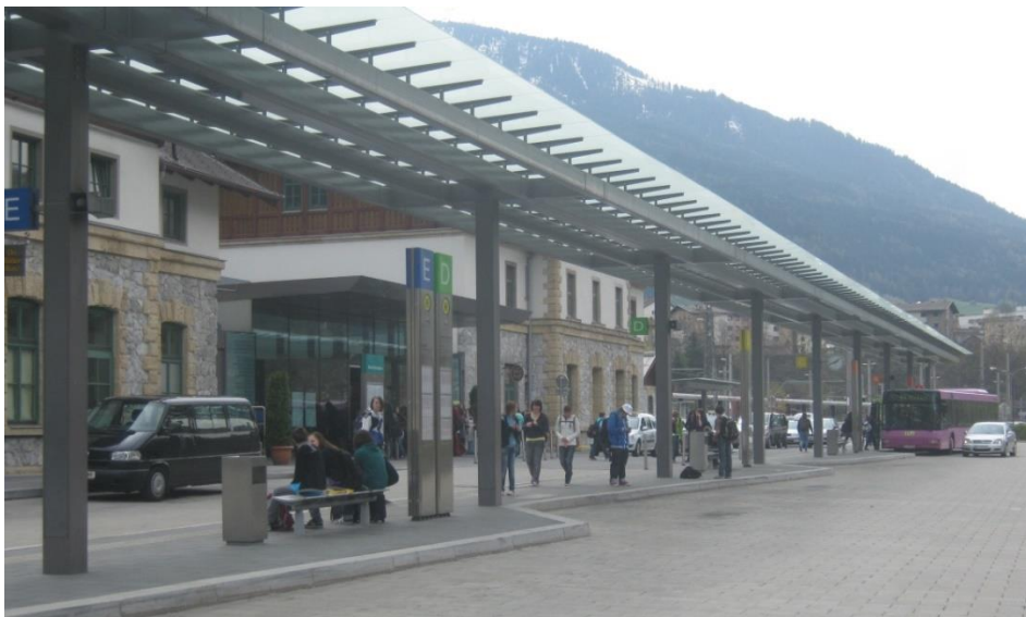
Rys. 11.1. Perony autobusowe przed dworcem kolejowym w miejscowości Landeck (Austria). Zaprojektowanie peronów w taki sposób ułatwia ich opuszczenie przez autobus.
