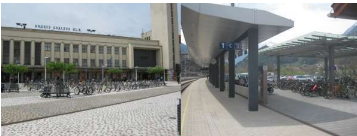
Rys. 12.3. Stojaki rowerowe w systemie B+R przed dworcem kolejowym Hradec Králové hlavní nádraží i stojaki rowerowe bezpośrednio przy peronie kolejowym na dworcu kolejowym w Landeck
