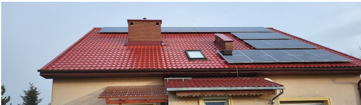
Rysunek 8 Mikroinstalacja fotowoltaiczna.
