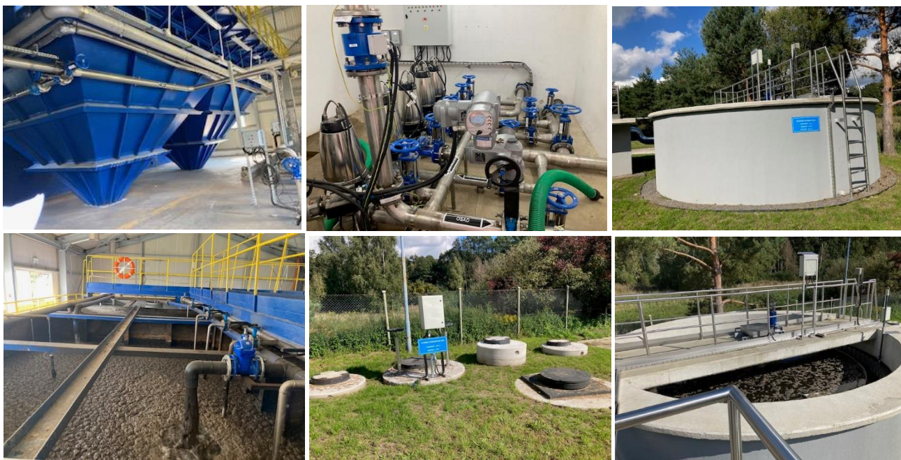
Rysunek 5 Przebudowa i rozbudowa oczyszczalni ścieków w miejscowości Raszków oraz rozbudowa sieci wody i sieci kanalizacji sanitarnej w miejscowości Raszków Gmina Lubin – PGK Gminy Lubin Sp. z o.o.
