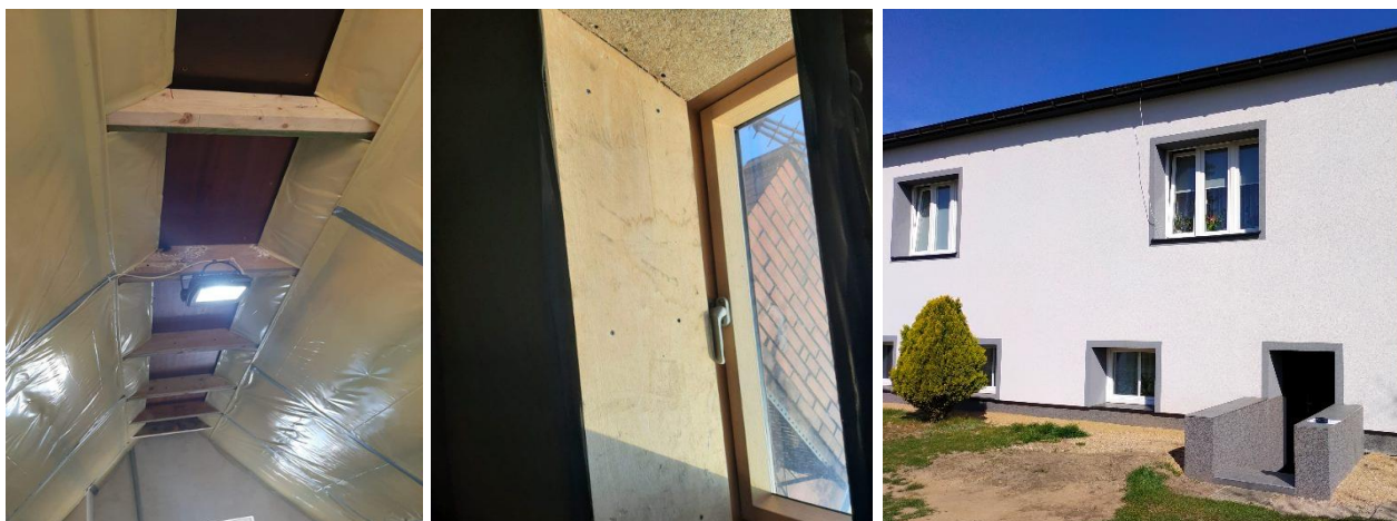
Rysunek 6 Termomodernizacja budynku.
