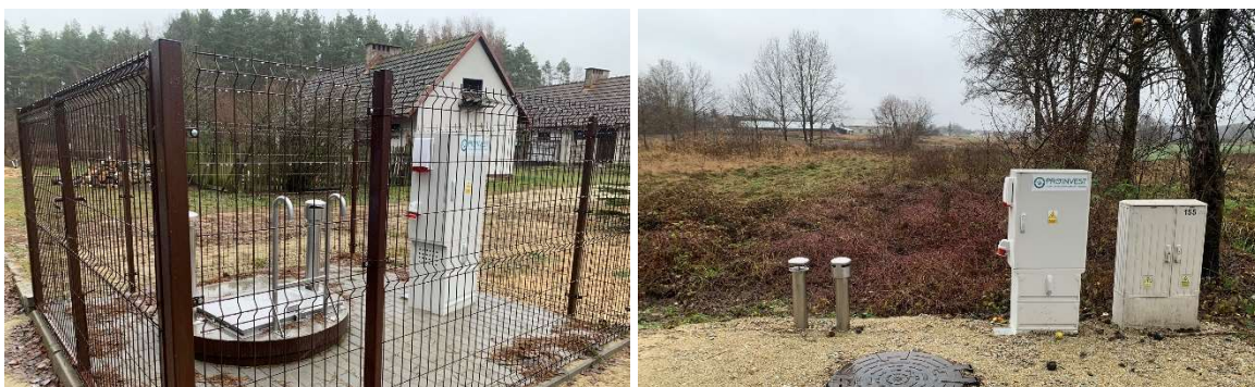
Zdjęcie 2. Budowa sieci kanalizacji wzdłuż drogi powiatowej nr 1450 wraz z przyłączeniami – Gmina Krośnice
