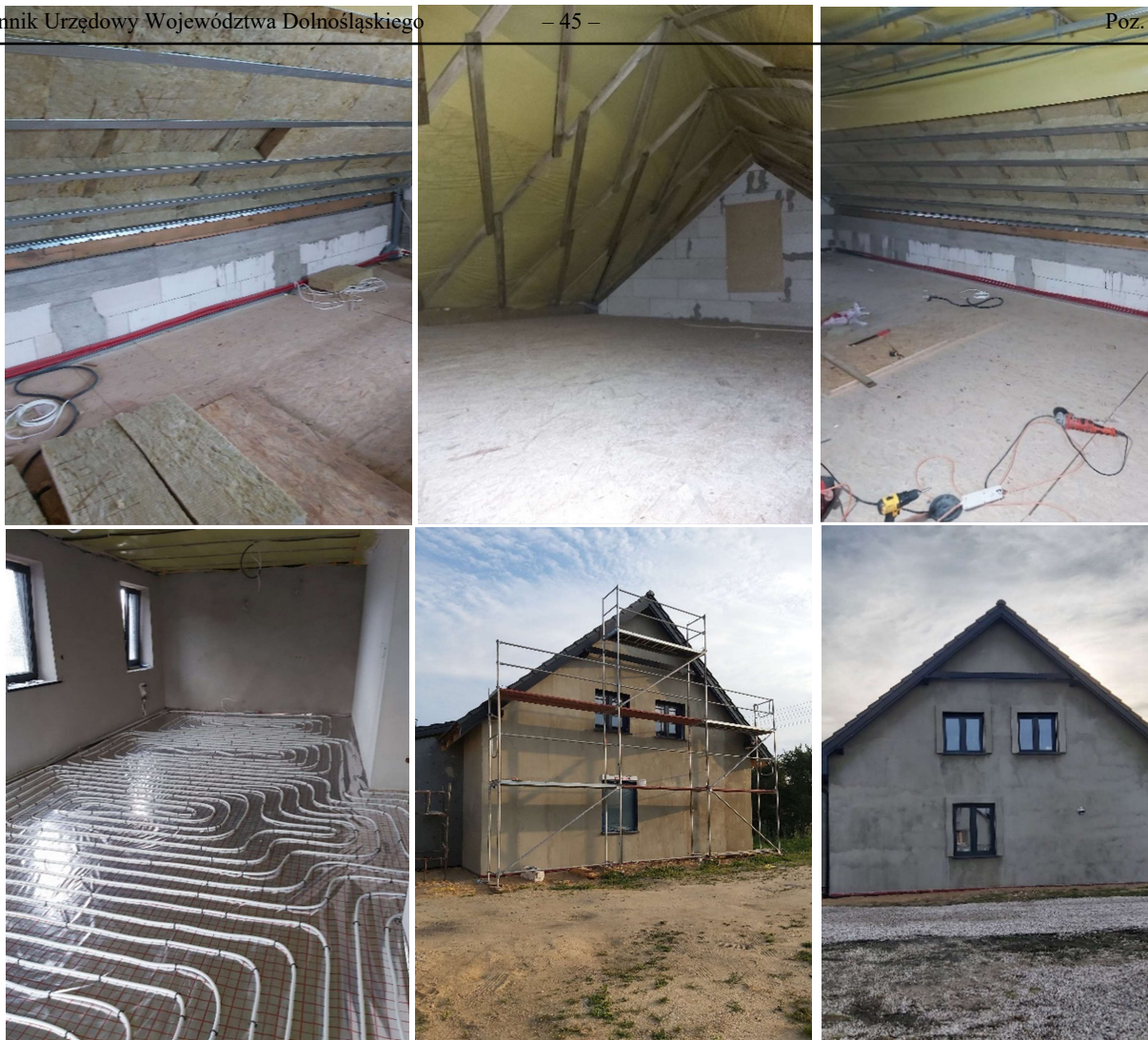
Zdjęcie 8. docieplenie przegród budowlanych, instalacja centralnego ogrzewania.
