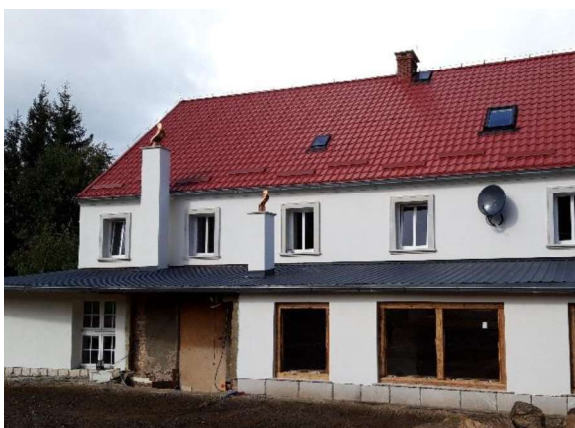
Rysunek 3. Termomodernizacja budynku gospodarstwa agroturystycznego „Kolorowy Raj” w Wieściszowicach
