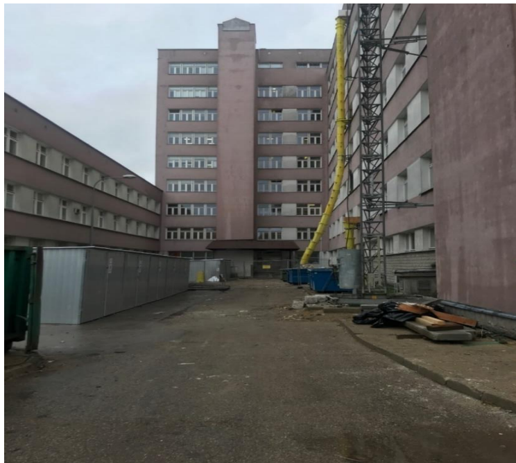
Foto 3. Widok elewacji UDSK (budynek A1)
